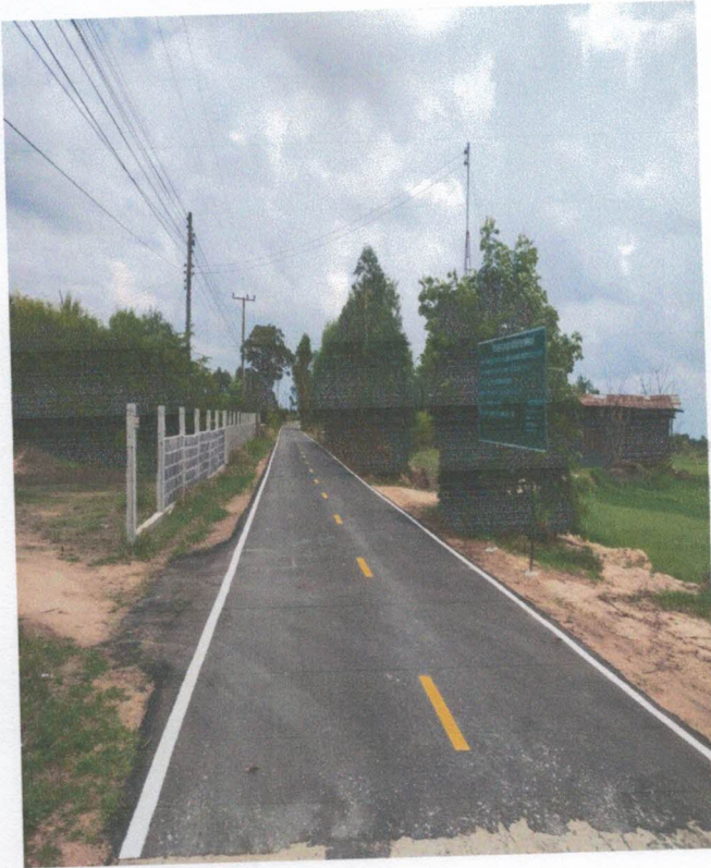
(2) โครงการซ่อมแซมเสริมผิวจราจรคอนกรีตเสริมเหล็กโดยวิธีการเสริมผิวจราจรแอสฟัลต์ติกคอนกรีต บ้านโพธิ์ศรี หมู่ที่ 8 ตำบลสระแก้ว อำเภอพนมไพร จังหวัดร้อยเอ็ด
