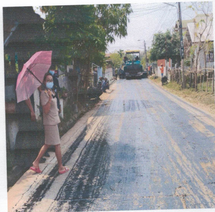
(3) โครงการซ่อมแซมเสริมผิวจราจรคอนกรีตเสริมเหล็กโดยวิธีการเสริมผิวจราจรแอสฟัลต์ติกคอนกรีต บ้านสระแก้ว หมู่ที่ 2 ตำบลสระแก้ว อำเภอพนมไพร จังหวัดร้อยเอ็ด
