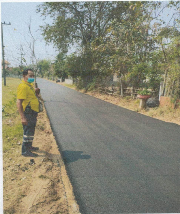
(4) โครงการซ่อมแซมเสริมผิวจราจรคอนกรีตเสริมเหล็กโดยวิธีการเสริมผิวจราจรแอสฟัลต์ติกคอนกรีต บ้านเจริญศิลป์ หมู่ที่ 1 ตำบลสระแก้ว อำเภอพนมไพร จังหวัดร้อยเอ็ด
