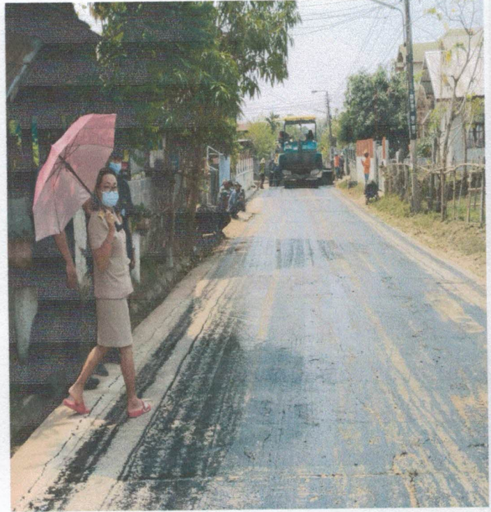
(4) โครงการซ่อมแซมเสริมผิวจราจรคอนกรีตเสริมเหล็กโดยวิธีการเสริมผิวจราจรแอสฟัลต์ติกคอนกรีต บ้านเจริญศิลป์ หมู่ที่ 1 ตำบลสระแก้ว อำเภอพนมไพร จังหวัดร้อยเอ็ด
