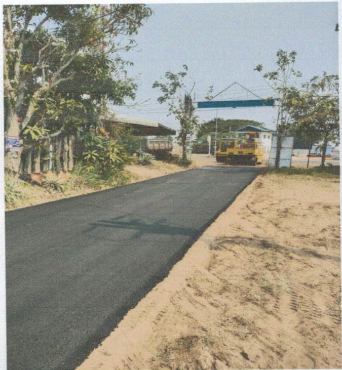
(4) โครงการซ่อมแซมเสริมผิวจราจรคอนกรีตเสริมเหล็กโดยวิธีการเสริมผิวจราจรแอสฟัลต์ติกคอนกรีต บ้านเจริญศิลป์ หมู่ที่ 1 ตำบลสระแก้ว อำเภอพนมไพร จังหวัดร้อยเอ็ด
